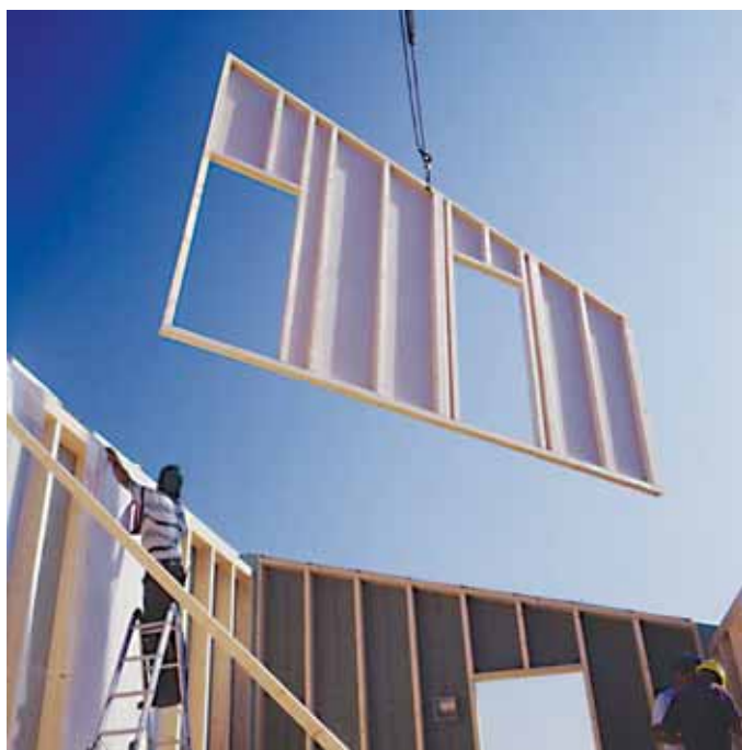
Bild 2 Montage von Wandtafelementen mit Beplankung aus Gipskartonplatten (Quelle: Knauf Gips KG)
