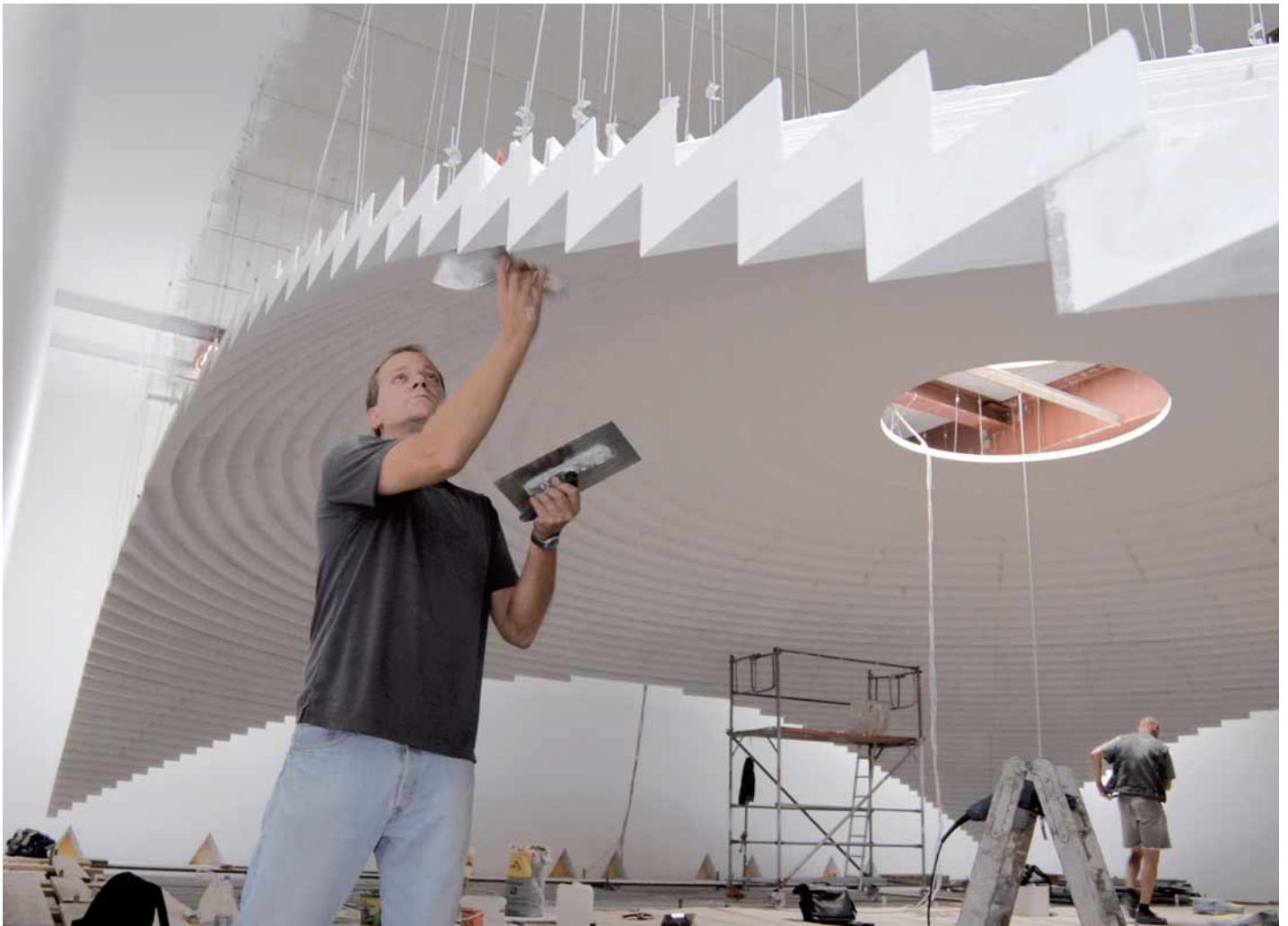
Phase der Fertigstellung. Die Kuppel hat einen Durchmesser von ca. 15 m, 4,50 m Höhendifferenz sowie 44 Abtreppungen. Sie besteht aus 126 Einzelteilen.
