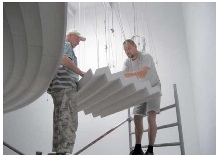
Kreisrundes Puzzle. Fertigungstechnisch hat Lafarge Gips die Kuppel mit ihren etwa 15 \text{ m} Durchmesser in Ringe aufgegliedert.
