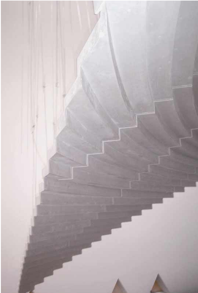
Minimalprinzip. Die mit 7 \text{ kg/m}^2 außerordentlich leichten Teile reduzieren Abhängewicht und -aufwand auf ein Minimum.
