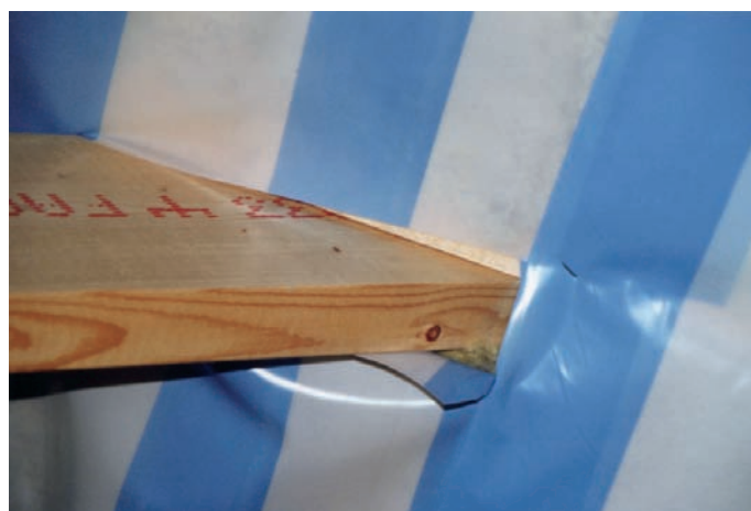
1 Dachgeschosse mit Kehlbalkenlage weisen eine Vielzahl von Durchdringungen auf, eine fachgerechte Abdichtung ist wirtschaftlich nicht möglich.
