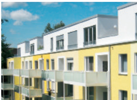
Sanierung mit eingeschossiger Aufstockung
