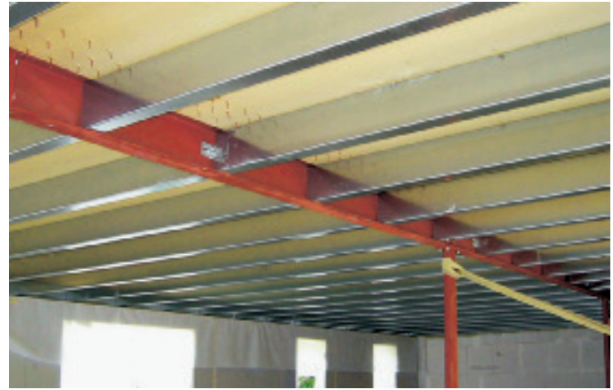
Untersicht der Decke
