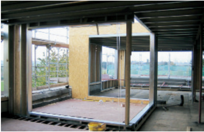
Wand- und Deckenelemente als Halbfertigteile vor Beplankung im Rahmen des Innenausbaus
