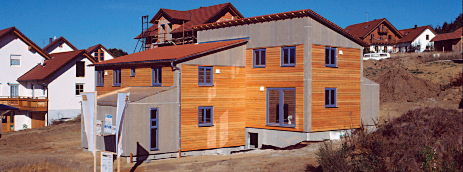
Bild 1: Gipskartonplatten dienen bei diesem Neubau in Holztafelbauweise als aussteifende und mittragende Beplankung
