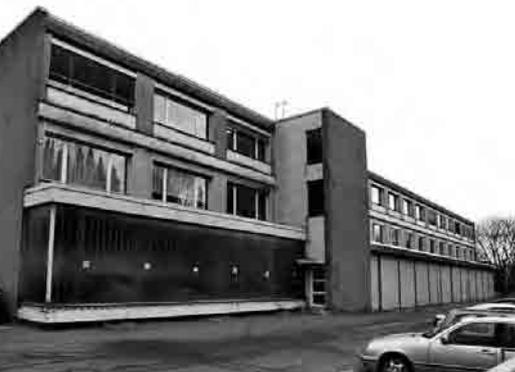
**VON INNEN NACH AUSSEN.** Hier fand eine gravierende Sanierung im Sinne der Flexibilisierung des Bestandsgebäudes statt. Nichttragende Trockenbauwände wurden als Außenwände eingesetzt. Diese bekamen nachträglich eine Haut aus Polycarbonat-Platten, die ein hohes Maß an solaren Gewinnen für die dahinter liegende Wand erzeugen. Durch die hochgedämmten Außenwände in Trockenbauweise und dem Konzept der Solarfassade ist auch dieses Gebäude nach der Sanierung hochenergieeffizient.
