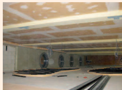
1 + 2 Schwimmbäder sind im Trockenbau heute machbar. Oben: Hotel Hochsauerland mit Gipsvliesplatten. (Foto: Siniat) Links: Schwimmpool Wuppertal – Faserzementplatten. (Foto: Peter Frese/Siniat)
